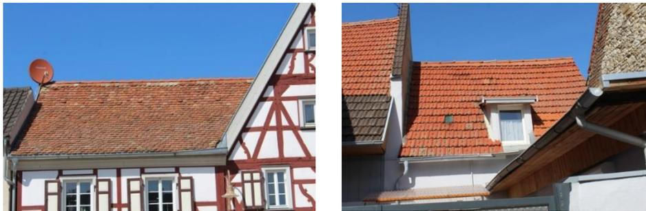
Abbildung: Biberschwanzziegeldeckung, Falzziegeldeckung
