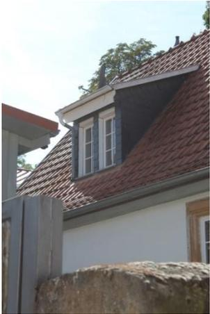
**Abbildung:** Schleppdachgaube mit Zwillingsfenstern
